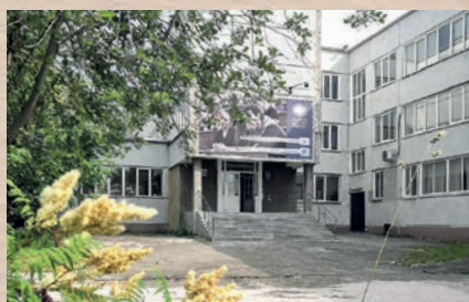
В 2003 году был построен 3 корпус университета, в котором разместились ИФМИП и ФТП НГПУ.
