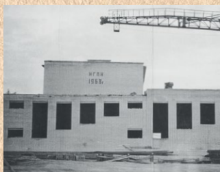
На фото: Строящееся здание на Ключ-Камышенском плато
